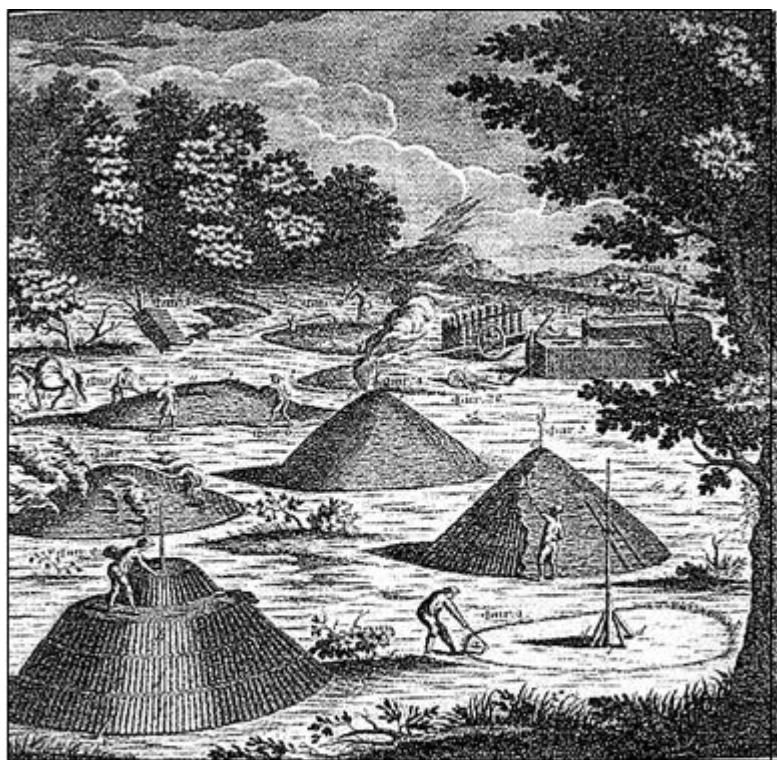
Въжигание древесного угля в куреньях. Иллюстрация из книги И. Шлаттера «Обстоятельное наставление рудному делу», изданной в 1760 г.
