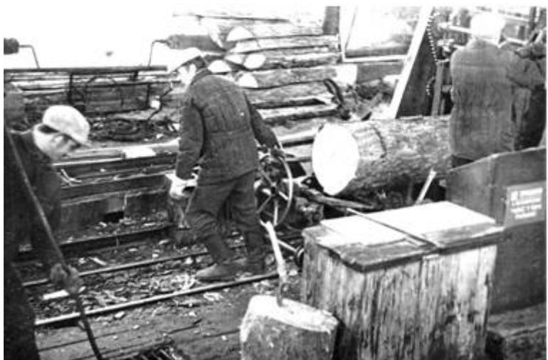
*Рис. 32. Тот же лесопильный цех до реконструкции. Свободного пространства нет, все завалено заготовками и отходами*
