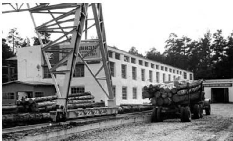
*Рис. 34. Общий вид лесопильного цеха после реконструкции. Здание было надстроено в высоту на 2,5 метра. Павловский ЛХ.*
