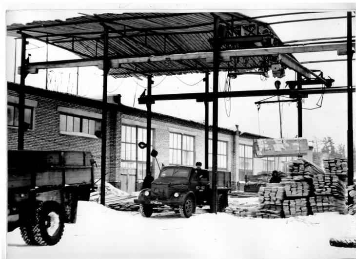
*Рис. 35а. Погрузка продукции кран-балкой на транспорт*
