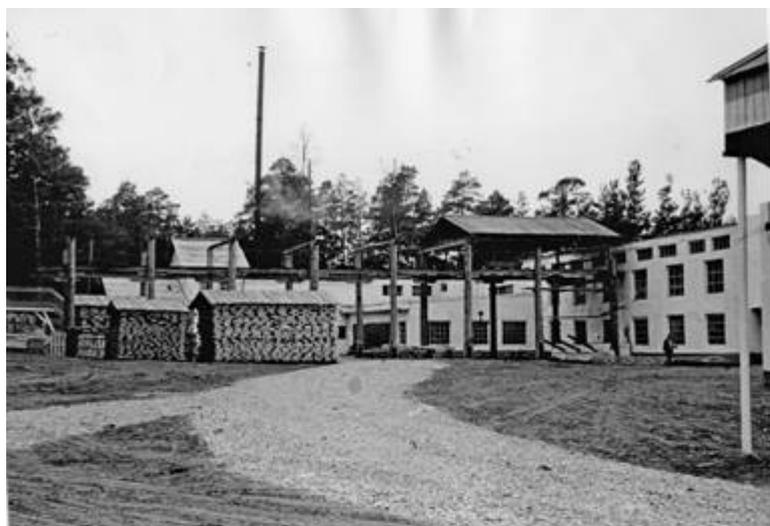
*Рис. 45. Общий вид территории цеха после реконструкции. На снимке видны штабеля пиломатериала, уложенного на естественную сушку.*
