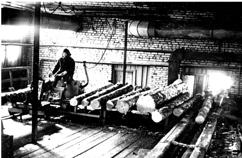
*Рис. 28. На снимке распространенная ошибка – подача в распиловку одним поставом бревен разных диаметров.*
