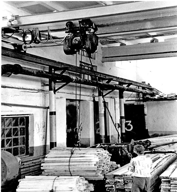
*Рис. 35. Перемещение пакетов внутри цеха кранбалкой.*
