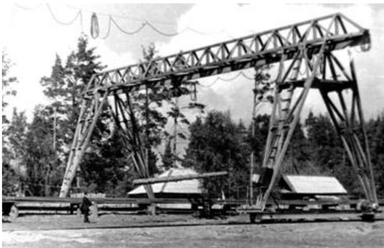
*Рис. 54. Козловый кран, конструкции филиала ЦНОТ, установленный на прицепном складе сырья в Ребрихинском лесхозе.*
