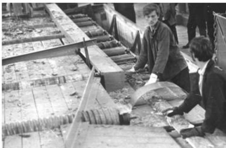
*Рис. 44. Торцовка горбыля в размер под заготовки для штакетника.*
