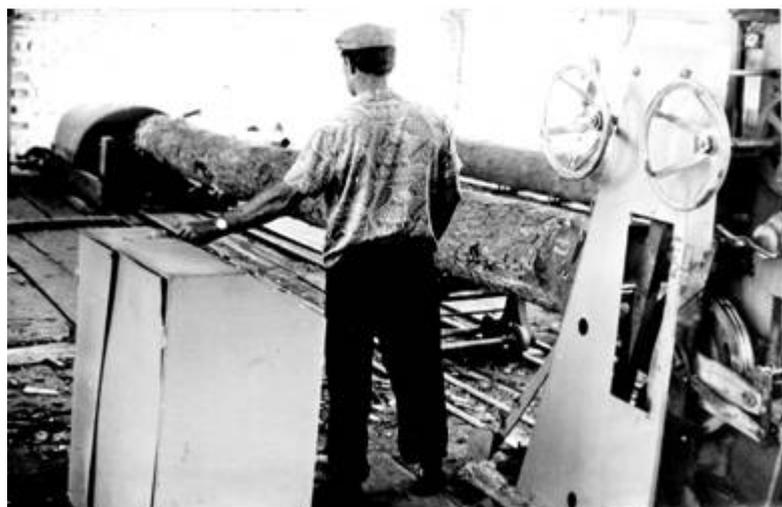
*Рис. 53. Механизированной тележкой управляет рамщик с пульта управления рамой. Ребрихинский лесхоз.*
