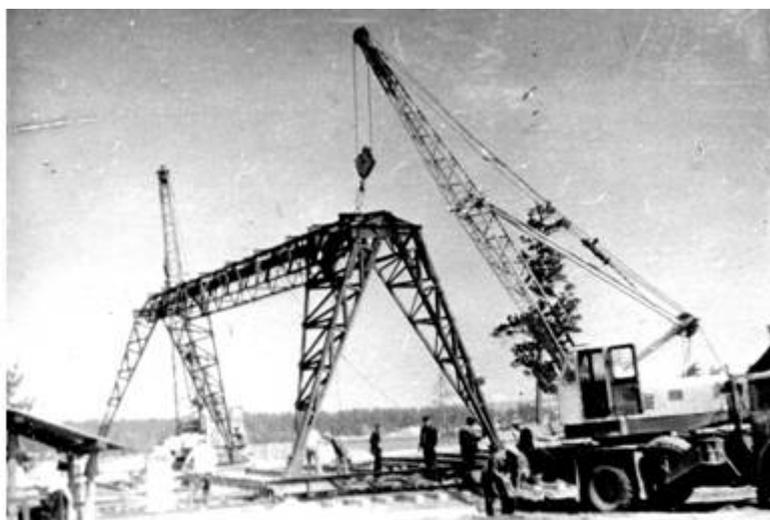
*Рис. 36. Монтаж козлового крана на причеховом складе сырья.
