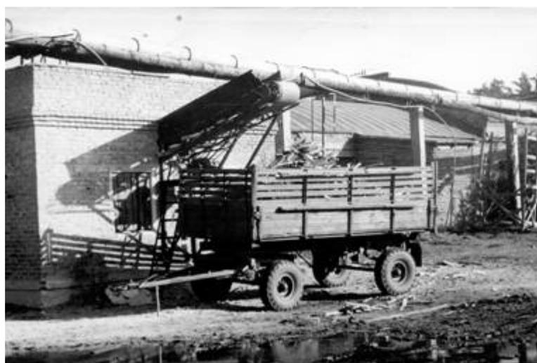
*Рис. 67. В этом варианте кусковые отходы из цеха удаляются ленточным транспортером сразу в тракторную тележку.*
