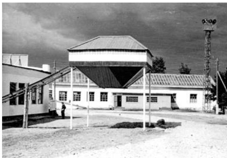
*Рис. 64. Бункер для отходов с открывающимся дном. Отходы из цеха подаются скребковым транспортером.*
