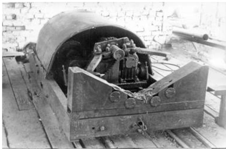
*Рис. 50. Общий вид механизированной впередирамной тележки, созданной конструкторским отделом филиала ЦНТО*
