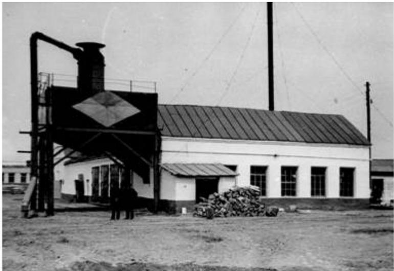
*Рис. 62. Котельная в Бобровском песокомбинате. Сюда в качестве топлива пневмотранспортом подаются опилки из лесотильного цеха*
