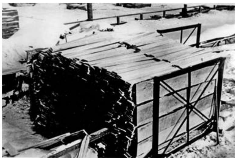
*Рис. 58. Пакетирование тарной дощечки в специальных кассетах.*
